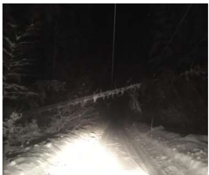
Baum über Stromleitung
